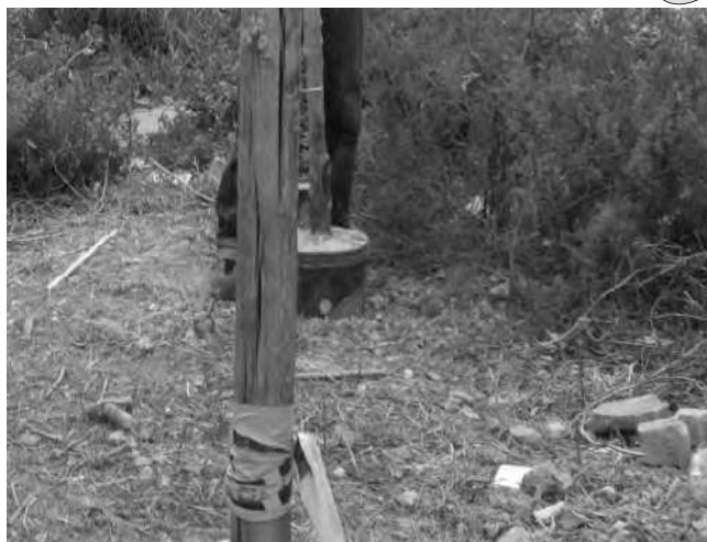
B.) Zona en demolición (ubicación nor-occidental de la ETITC).
